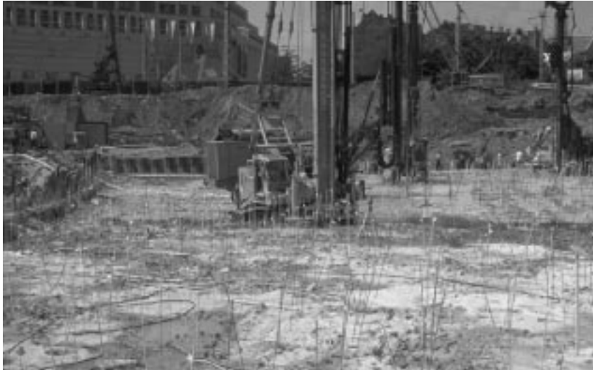
Abb. 5.8: Einrütteln der Injektionslanzen vor der Weichgelinjektion (aus EISWIRTH, OHLENBUSCH & SCHNELL 1997)
